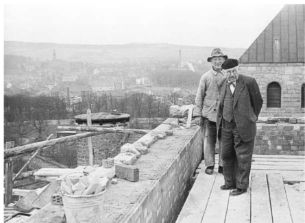
Polier Walter Schmidt (hinten) informiert den damaligen HAZ-Chefredakteur Max Höhne über den Baufortschritt (1952).
