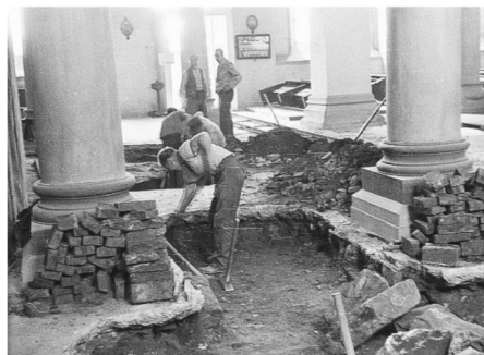
Innenarbeiten: Im Kirchenschiff wird der Einbau der Fußbodenheizung vorbereitet.
