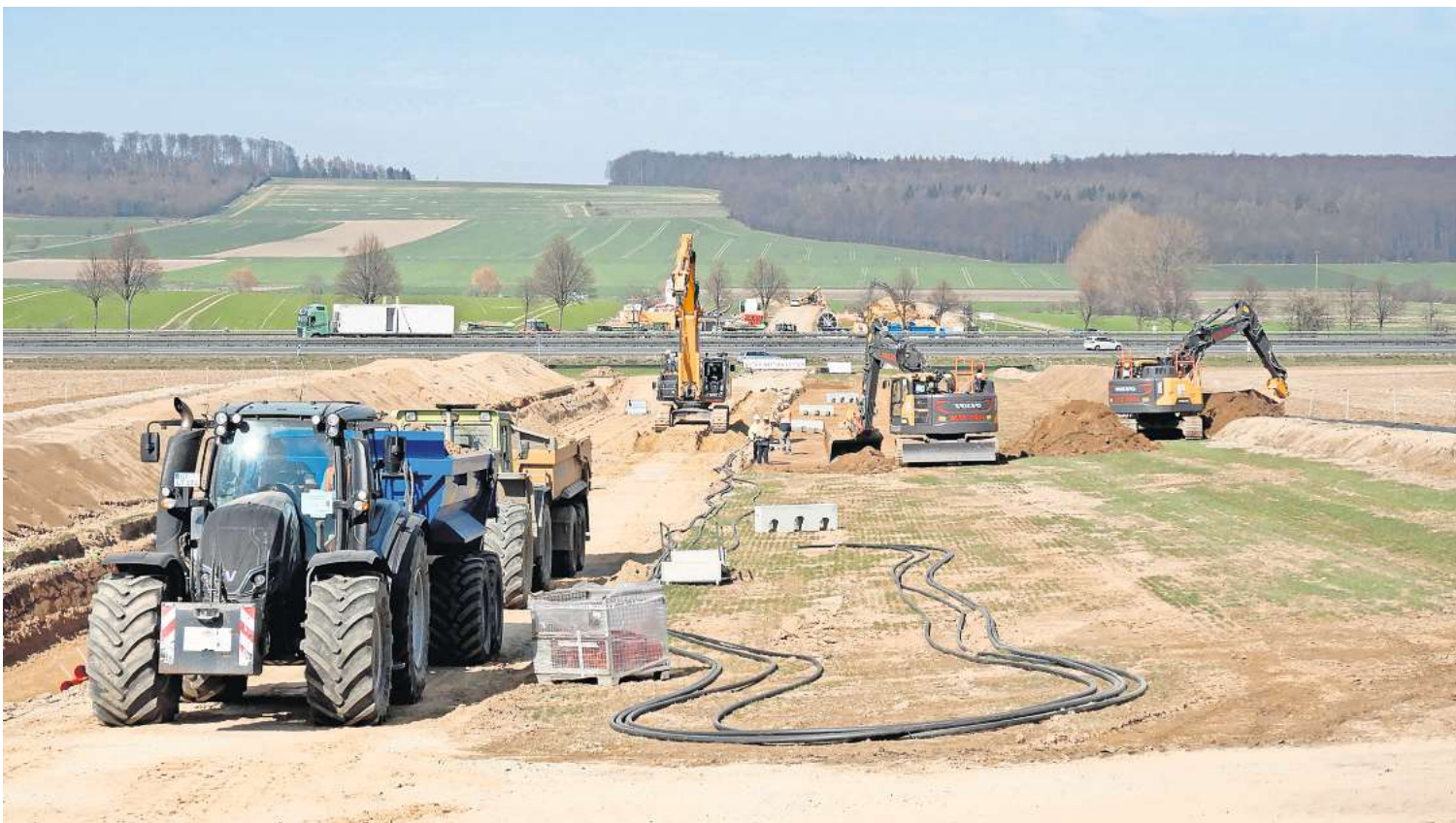
Erdkabelbaustelle bei Wartjenstedt für die neue Höchstspannungsleitung im Jahr 2020. Die nächsten Baustellen werden folgen. FOTO: HAZ/ARCHIV
