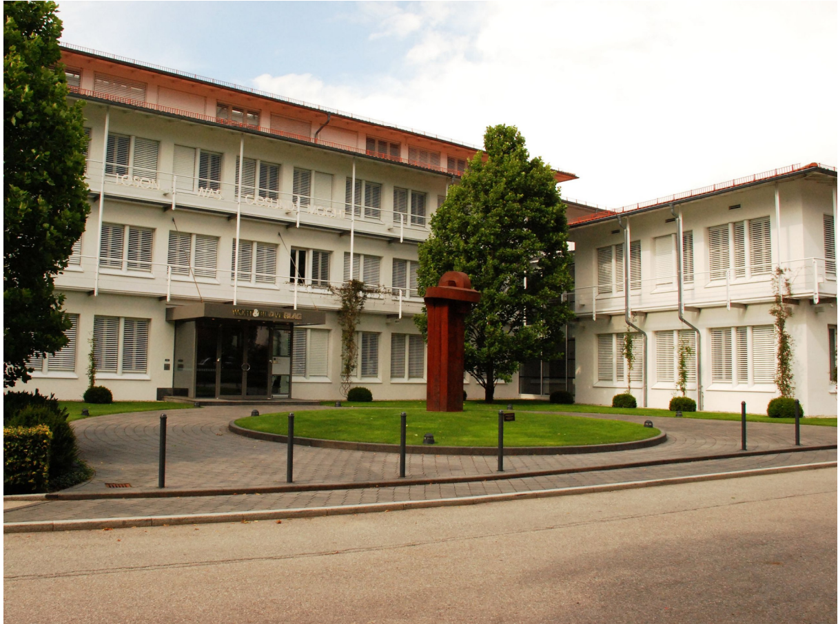
Haus 5 der Verlagsgebäude
