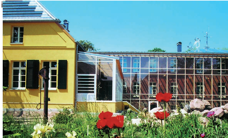
Das solar energetisch sanierte Gutshaus - hier mit Glasveranda, Quelle: Solarzentrum MV
